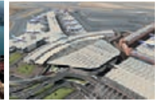
Kahire Havalimanı Yapısal Mesnetler
