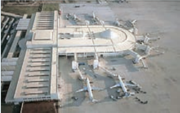
Antalya Havalimanı Terminal Binası
