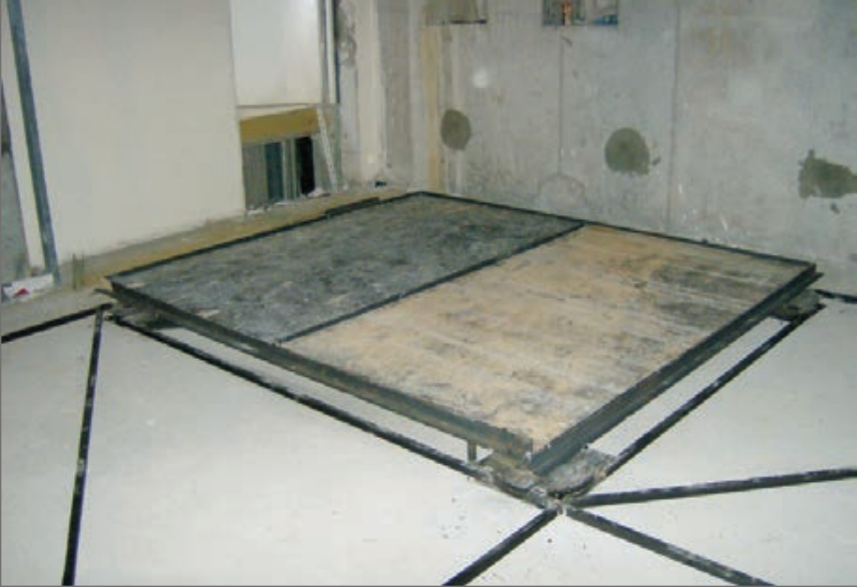
Yalıtım birimlerinin yerinde uygulanmasında birim modül
