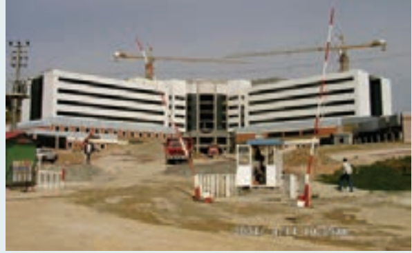
KOU Hastane Binası
