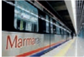
Marmaray Yapısal Mesnetler
